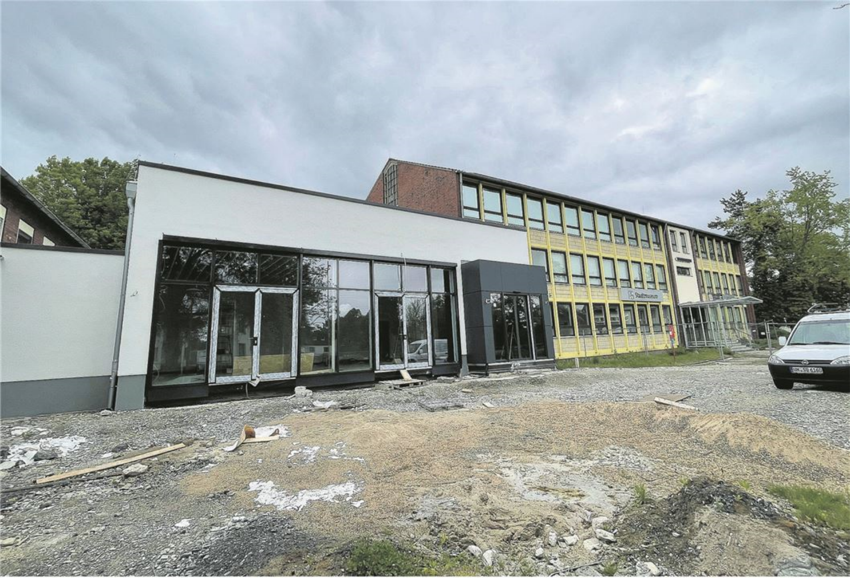
Das Stadtmuseum in Bergkamen wird aktuell umgebaut und bekommt auch einen Anbau. Jetzt wurde über die Gestaltung des Cafés entschieden.
